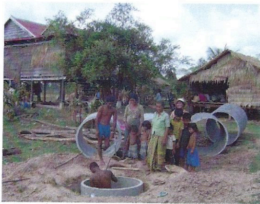
Scavo di un pozzo.
